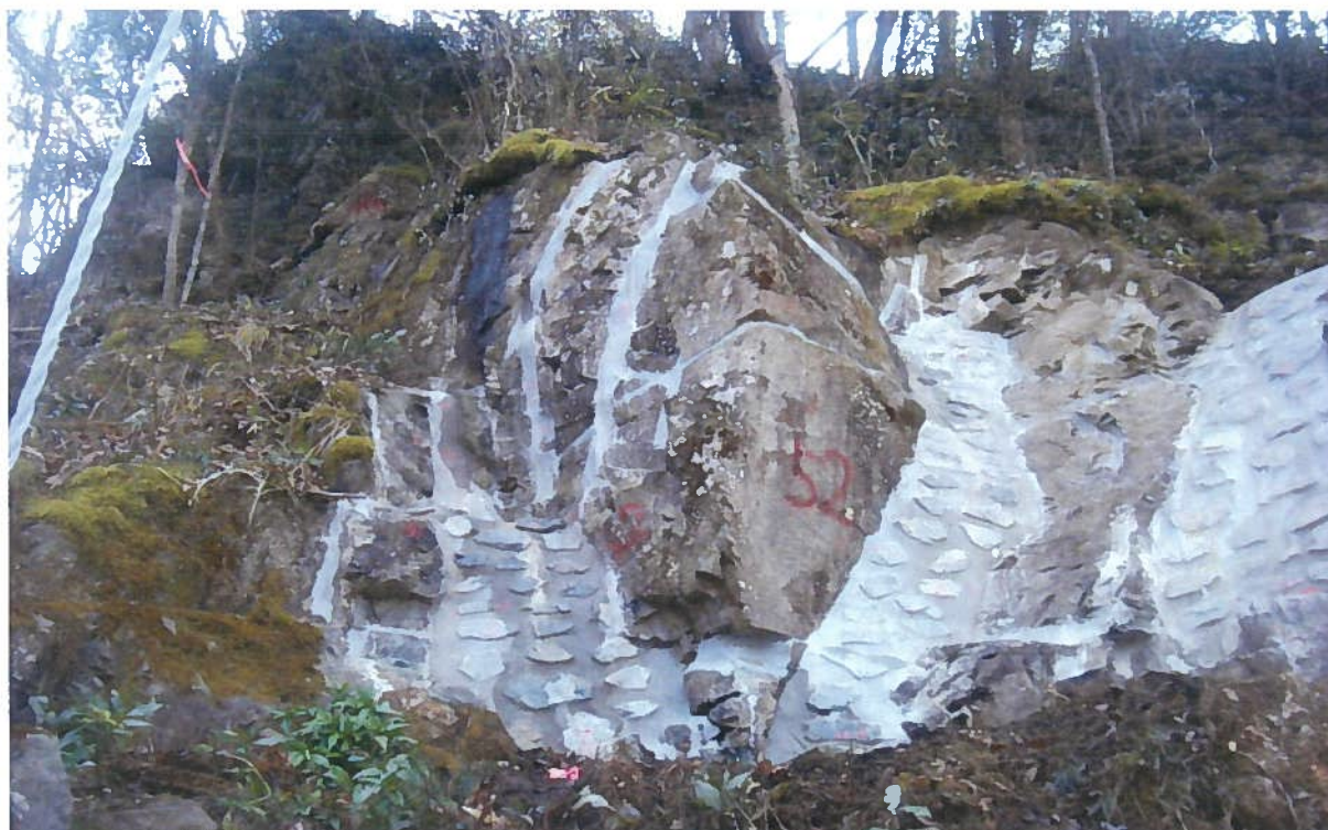
2014 年度施工 岡山県吉備中央町富永・下土井地内
