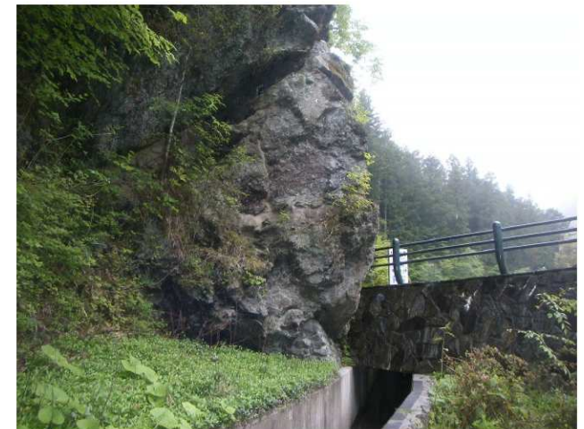
19 国道194号 交通安全施設等整備工事
