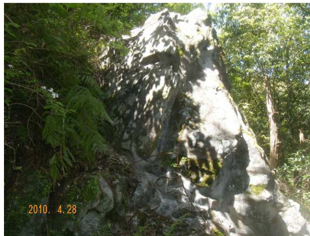
17 第72号 貝の川復旧治山工事
