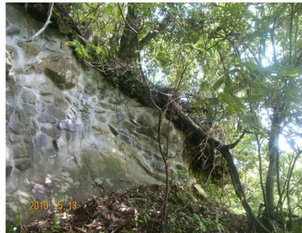
18 平成10年度 磯ノ川防災3件工事
