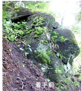
4-2413 担い手育成基盤整備事業中渡地区第14605号工事
