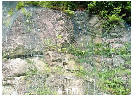
2-2387 県単道路災害防除工事(藤琴国有林工区)
