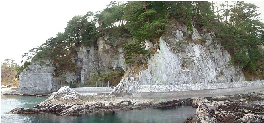
5-1596 浄土ヶ浜道路(歩道)落石防止工事
