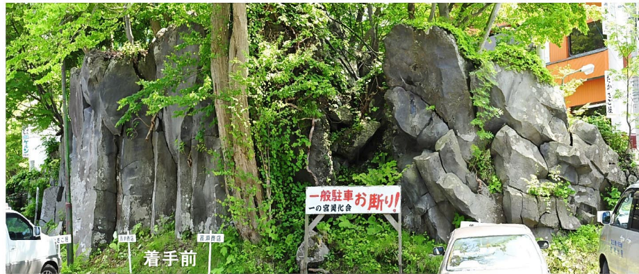
7-2574 休屋園地一の宮岩盤修繕工事
