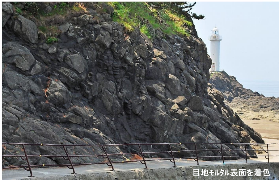
12-2746 鼠ヶ関港弁天島遊歩道落石対策工事
