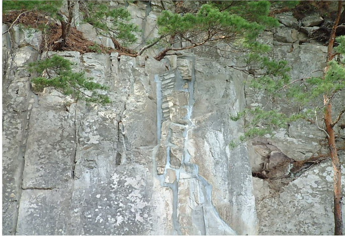
5-1596 浄土ヶ浜道路(歩道)落石防止工事
